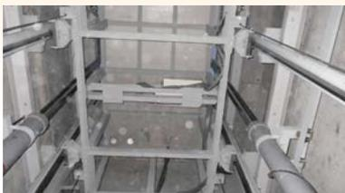
油圧プランジャーを使用し、カゴを直接昇降させるシンプルな構造。使用部品が少ないので、他の方式と比べて故障が少ないのが特徴です。メンテナンスも容易でランニングコストの軽減が可能です。
