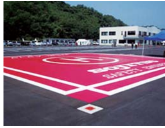
コンクリート舗装 (外周部:アスファルト)+マーキング 航空灯火設備+ 「空から点灯」システム
