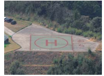
コンクリート舗装+マーキング 航空灯火設備
