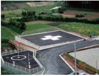
アスファルト舗装+マーキング 航空灯火設備+ 「空から点灯」システム
